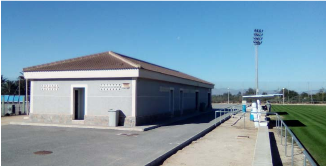
Imagen 2. Edificio Pista exterior
